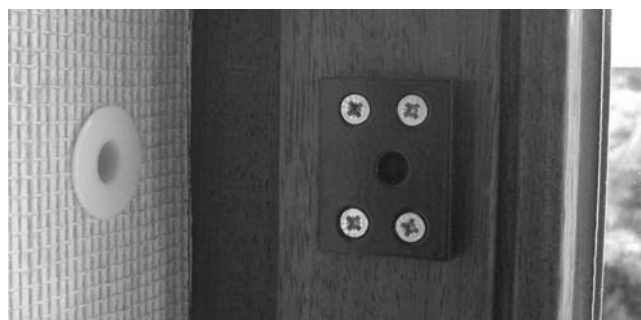
Abb.: Bandsicherung BS2 (Riegel entnommen) ▶
